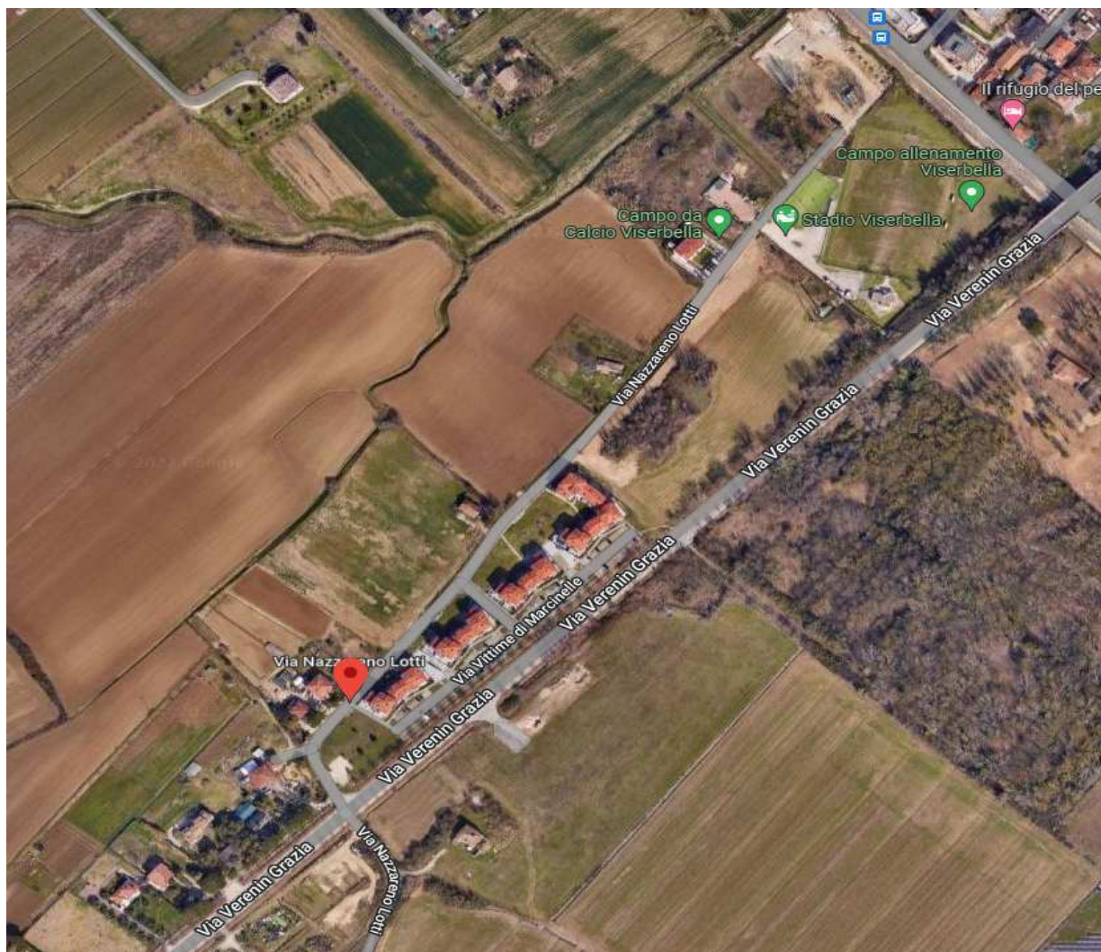
Veduta aereo-fotogrammetrica dell'area oggetto di intervento
