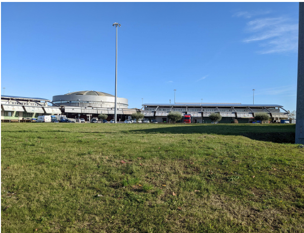
Vista del lotto di edificazione del Padiglione 4
