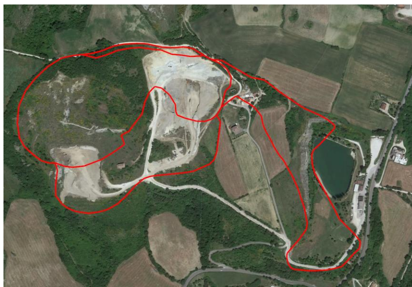
Fig- 9 – immagine Google 2017. In evidenza l'area nella quale sono in corso le attività di scavo (residuali) e sulla sinistra l'area dove sono in corso le opere di sistemazione morfologica. Sulla destra nella foto il sub-ambito 2-2 già sistemato (confermine all'invaso).
