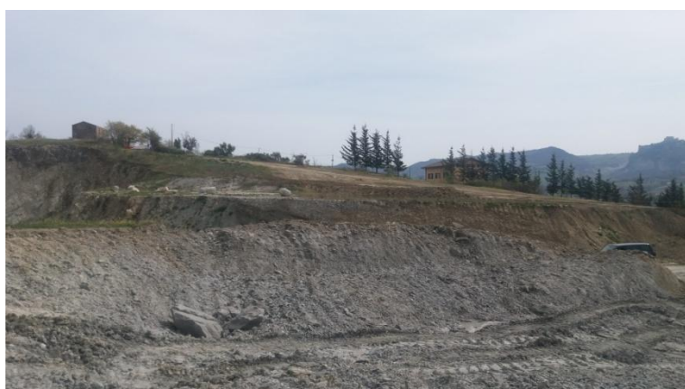
Foto 3 – dettaglio zona sulla quale in linea generale si svilupperà l'attività estrattiva futura, approfondendo lo scavo.
