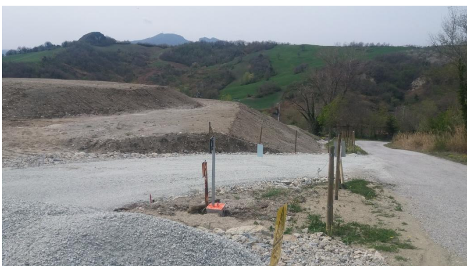
Foto 6 - interventi di sistemazione morfologica contestuali alle operazioni di scavo nel settore dove ora si concentra l'attività estrattiva.
