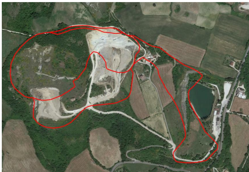
Fig- 9 – immagine Google 2017. In evidenza l’area nella quale sono in corso le attività di scavo (residuali) e sulla sinistra l’area dove sono in corso le opere di sistemazione morfologica. Sulla destra nella foto il sub-ambito 2-2 già sistemato (contermine all’invaso).
