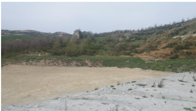
Foto 2 – panoramica dell'area dove sono in corso le operazioni di sistemazione finale morfologica.
