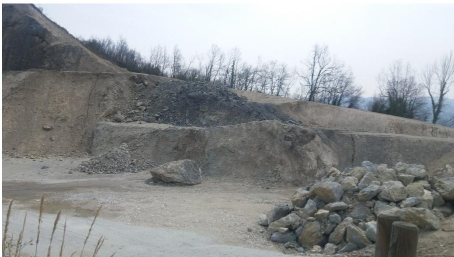
Foto 5 - dettaglio della zona di scavo attuale ed in corso di esaurimento.
