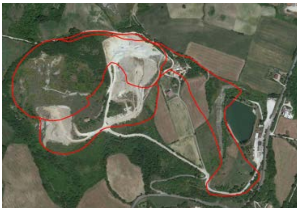
Fig- 30 - immagine Google 2017. In evidenza l'area nella quale sono in corso le attività di scavo (residuali) e sulla sinistra l'area dove sono in corso le opere di sistemazione morfologica. Sulla destra nella foto il sub-ambito 2-2 già sistemato (conferme all'invaso).
